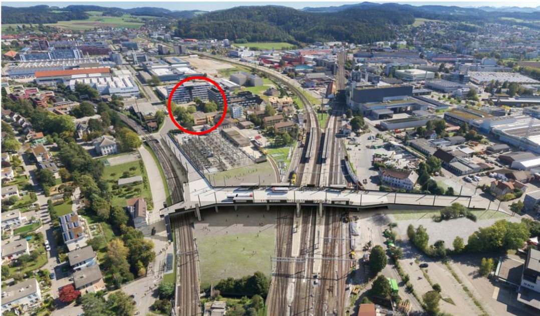
Umfeld Grüze mit neuer Querung Grüze und Baufeld 4
